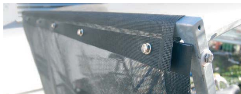
Detailansicht der Befestigung des Gittergewebes
