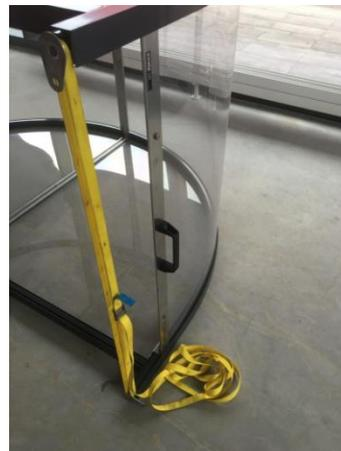
19) Vertikaltraversen innen zusammen mit dem Abschluss Falzblech / Horizontalverbinder montieren. (Bögen mit Spannsatz zusammenhalten)
