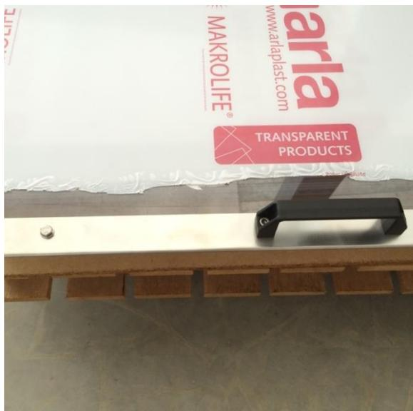
**Abschluss-Falzblech hinten montieren**
