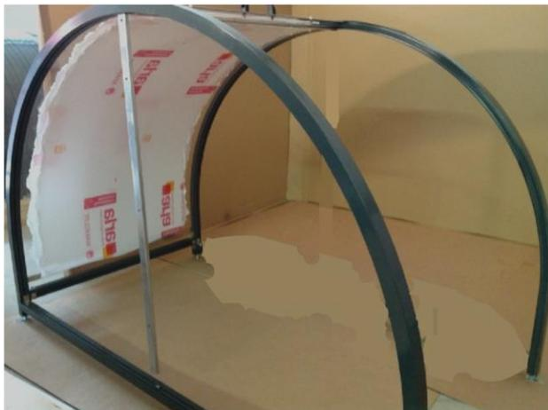
19) Seitenscheiben in Aussennute einsetzen (Nute mit einem, mit Virola Universal Oil getränkten Lappen wenig einölen)
