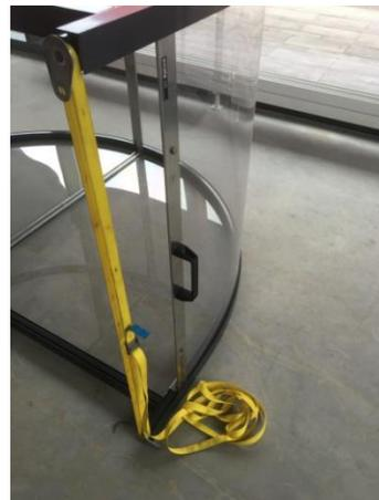
18) Vertikaltraversen innen zusammen mit dem Abschluss Falzblech / Horizontalverbinder montieren. (Bögen mit Spannsatz zusammenhalten)
