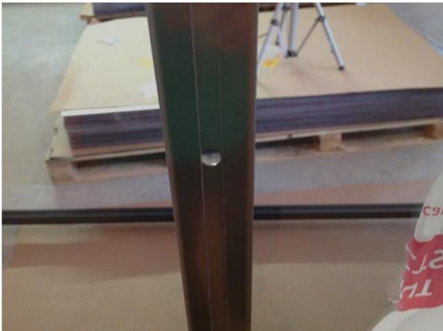
**22) Vertikaltraverse innen, unten mit Längsverbinder verschrauben**
